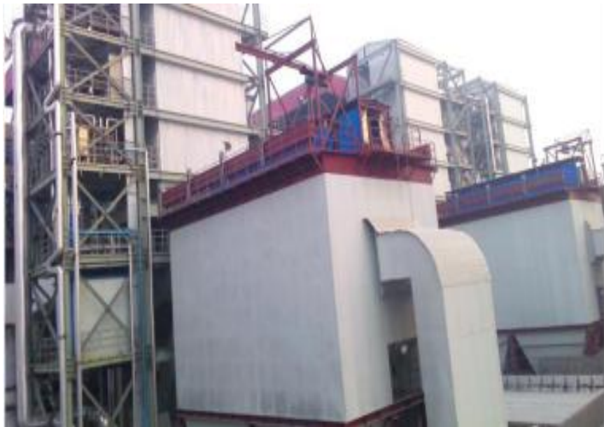
热电锅炉除尘脱硫脱硝废水系统工程项目
