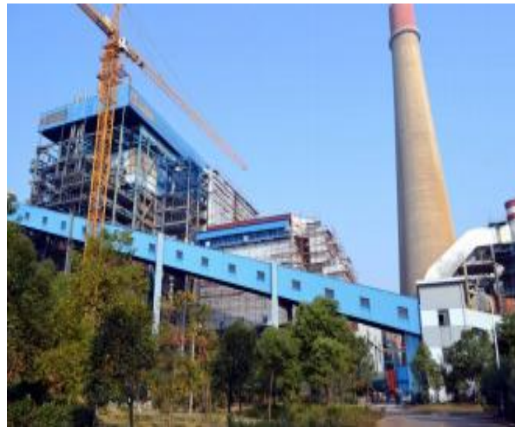
电厂脱硝工程项目
