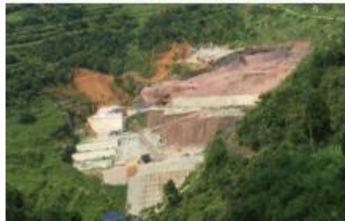
矿山污染治理工程
